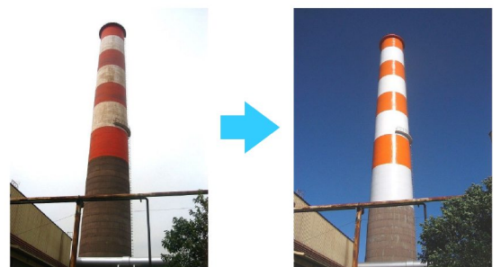
炭素繊維補強+外壁塗装
